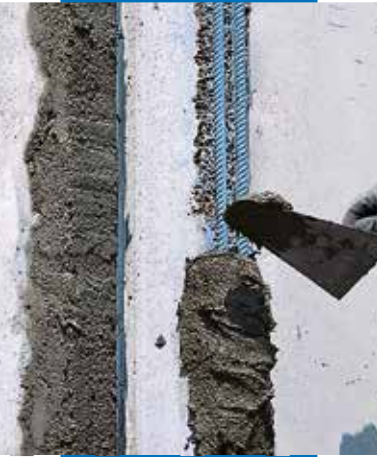
Нанесение раствора мастерком
