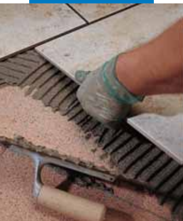
Укладка плитки одинарного обжига на стену снаружи помещения, облицованную терраццо
